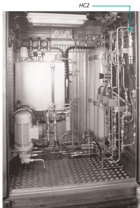
Panel de control de pozo
